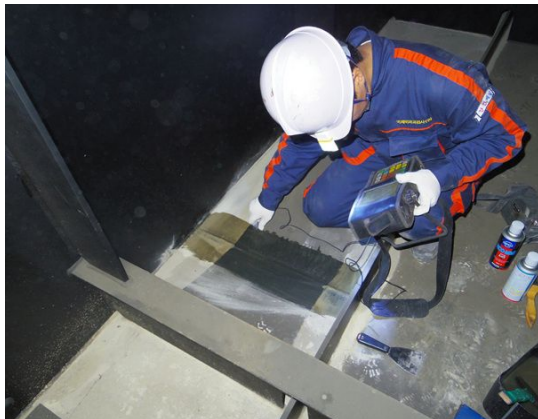
위 치 거더 내부 내 용 강재 초음파 탐상
