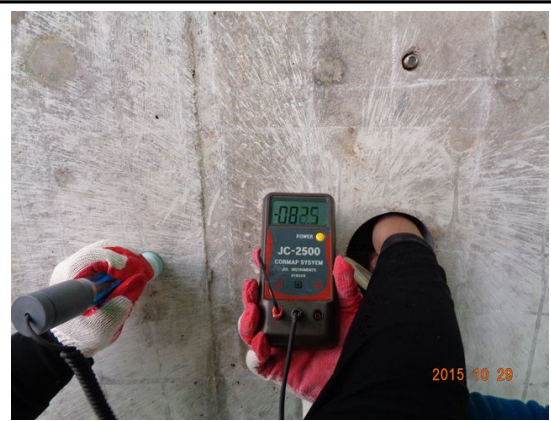
위 치 교각 내 용 철근부식도 측정현황
