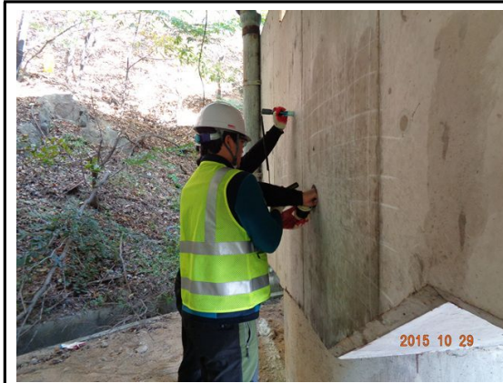
위 치 교각 내 용 철근부식도 측정현황
