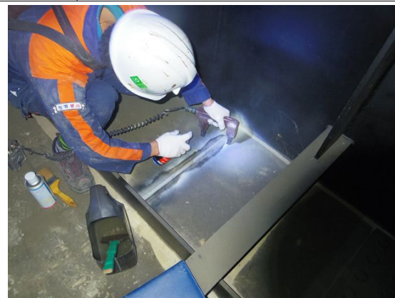
위 치 거더 내부 내 용 자분탐상 시험
